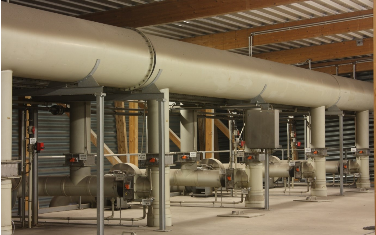
Abbildung 13: Lüftungstechnik auf dem Dach der Rottetunnel der MBA Großfehn [Foto: Martin Kieninger 2013]
