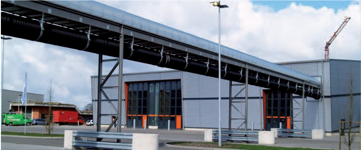
Abbildung 8: Halle zur mechanischen Aufbereitung mit Förderband zur biologischen Stufe auf der MBA-Anlage in Großefehn [MKW GmbH & Co. KG 2015]
