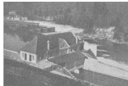
W 136 Wasserkraftwerk 1907 BAUM 1913
