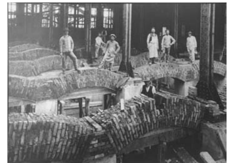
21 Augsburg Spinnerei und Weberei Augsburg Kellerdecke im Bau Archiv Thormann & Stiefel, Augsburg
