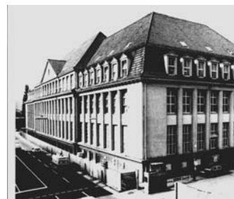
W 133 Wohlfahrtsbau 1916/17 LDABW
