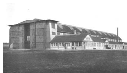
W 82 Werkstätten und Luftschiffhalle 1910
