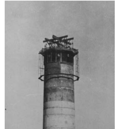
25 Reutlingen Baugerüst am Kaminkopf 1903 Archiv Robert Bosch AG, Reutlingen
