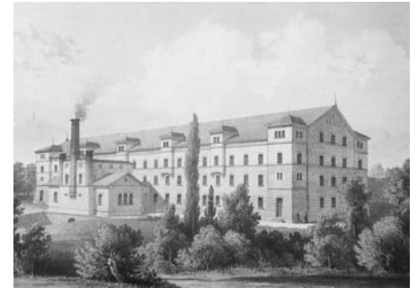
32 Altenstadt, Spinnerei Staub Rieter-Bauweise, „überformt“ von Georg Morlok 1857 KÖHLE-HEZINGER/ZIEGLER 1991 07
