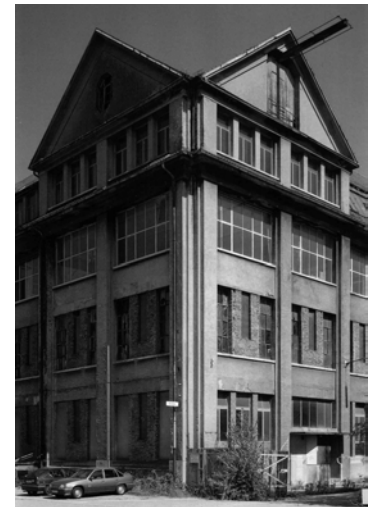
53 Karlsruhe Deutsche Waffen- und Munitionsfabrik Bau A, Ecksituation Dirk Altenkirch, Karlsruhe
