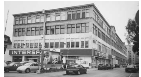
W 375 Produktionsbau Zustand 2003 Archiv Renz
