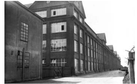
2 Karlsruhe Bau A der Deutschen Waffen- und Munitionsfabriken um 1930 KABIERKE 1993
