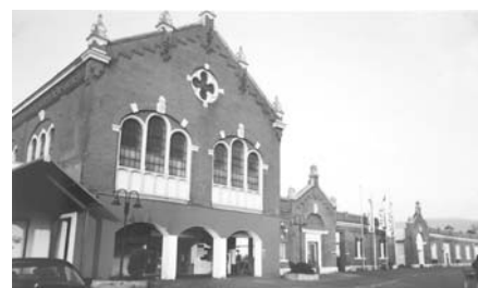
W 56 Maschinenhaus Werk III 1902 Archiv Renz
