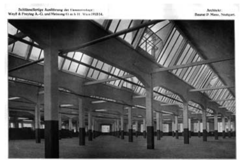
Waffenfabrik Steyr, Interieur des Shedhauses D. Die vorgesehene kurze Baueinheit von 180 Arbeitsplätzen für die Herstellung der unteren (Hoch- und Tiefbau), von denen eine eine Fläche von 90.000 qm (die Shedhalle allein 30.000 qm) bedecken, konnte noch unterbren werden, was durch Zahlung einer Pacht ausgemacht wurde.
