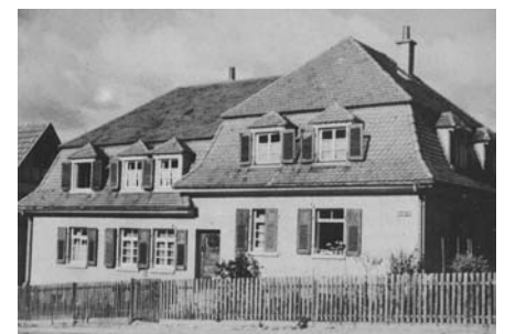
W 315 Doppelhaus Arbeiterkolonie 1922 Archiv Aesculap
