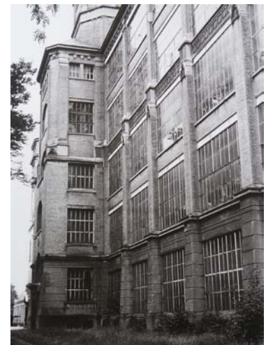
43 Augsburg Spinnerei und Weberei Augsburg Fassade 1909 von HAGEN/WEGENER-HÜSSEN 1994
