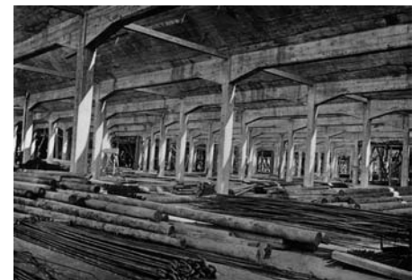
12 Steyr Österreichische Waffenfabriks-Gesellschaft Shedhalle im Bau 1913 Museum Arbeitswelt Steyr
