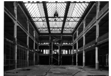
51 Karlsruhe Deutsche Waffen- und Munitionsfabrik Bau A, Lichthof Dirk Altenkirch, Karlsruhe
