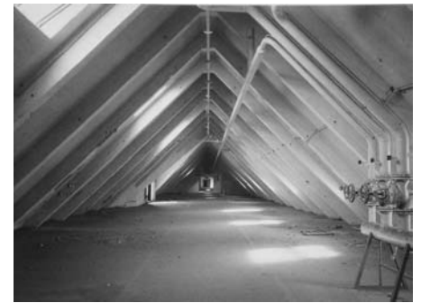
52 Karlsruhe Deutsche Waffen- und Munitionsfabrik Bau A, Spitzboden Dirk Altenkirch, Karlsruhe
