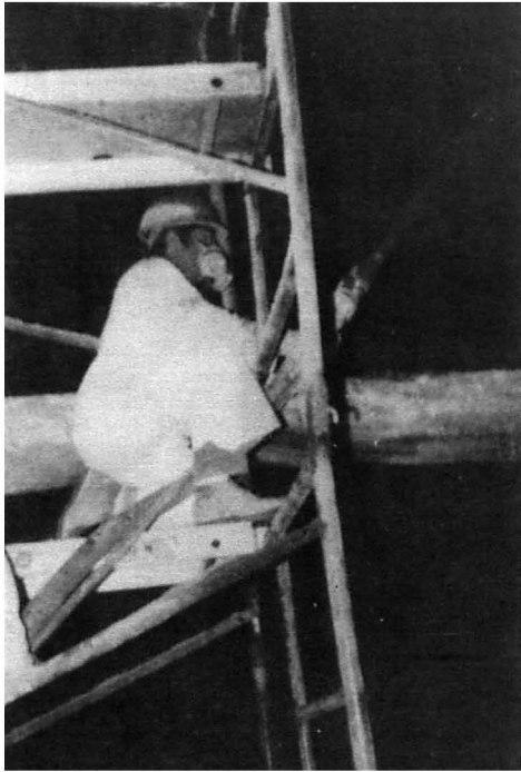
Abb.2-17: Torkretierarbeiten im Inneren der Schalung. /78/.
