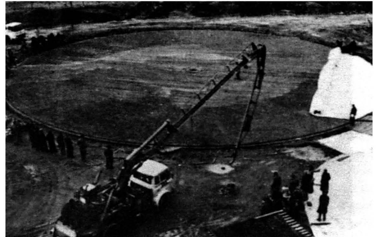
Abb.2-33: Aufbringen der oberen Membrane. /148/.
