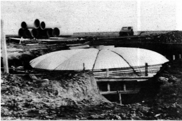
Abb.2-24: Die Schalung hat ihre endgültige Form erreicht. Die kreisrunde Abschaltung am Pol der Schalung stellt eine spätere Einstiegsöffnung her.
