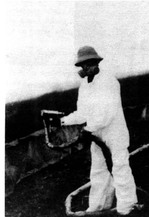
Abb.2-16: Aufspritzen von PU-Schaum auf die Innenseite der pneumatisch gestützten Schalung. /78/.
