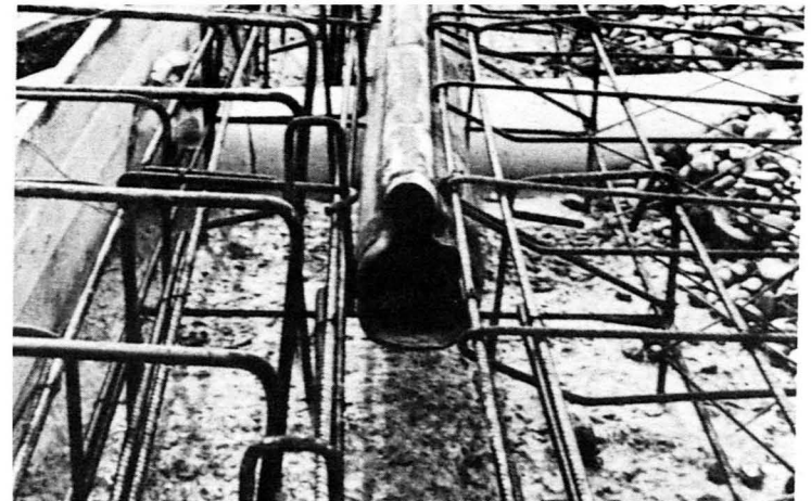
Abb.2-27: Bini-Verfahren: Mit Hilfe einer Schlauchschalung wird eine Nut im Betonfundament hergestellt. /148/.
