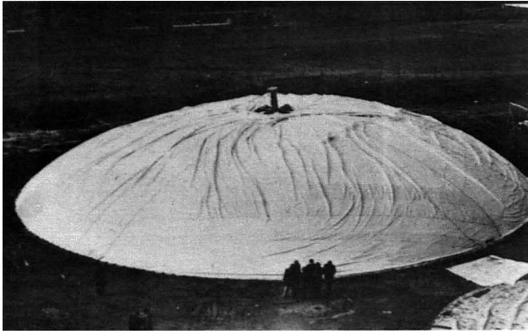
Abb.2-34: Die Schalung während dem Aufpumpen. /148/.
