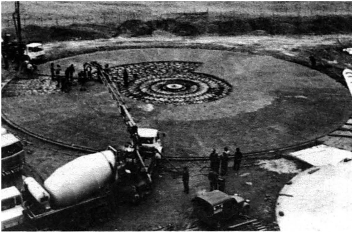
Abb.2-32: Aufbringen des Betons. /148/.
