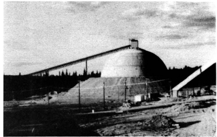
Abb.2-13: Ansicht der fertigen Schale. /100/.
