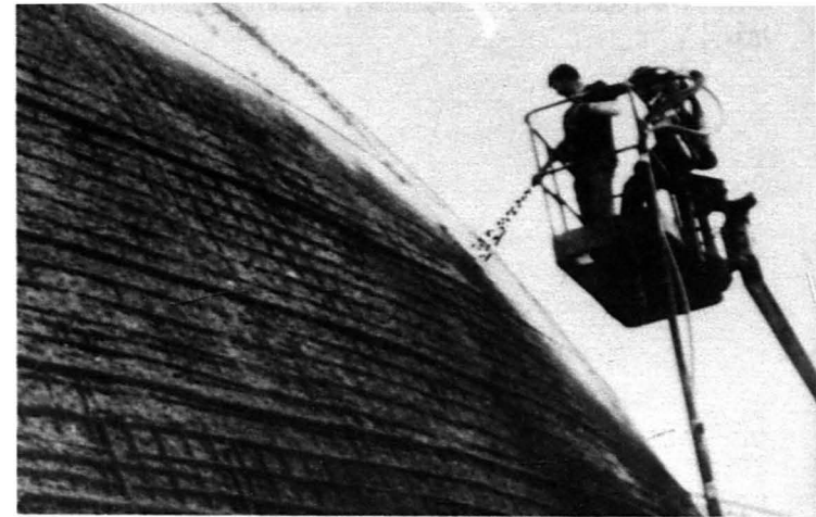
Abb.2-11: Die erste Betonschicht wird torkretiert. /100/.
