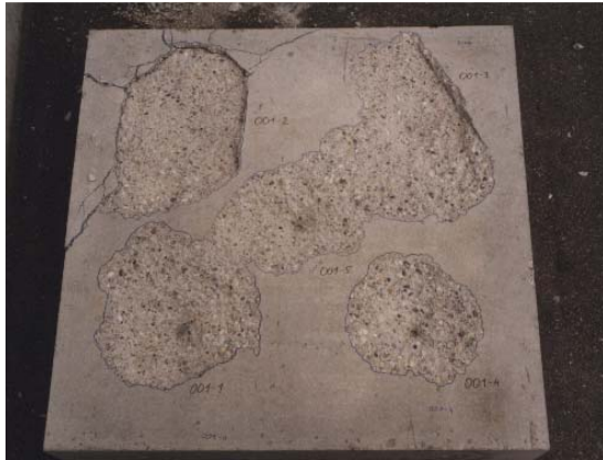
Bild 5.90: Ausbruchkegel der Kopfbolzen
