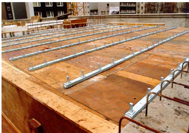
Bild 6.1: Einbausituation für Ankerschienenmeterware
