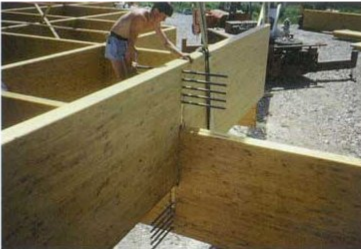
Abbildung 2.10: Knoten im Trägerrost nach BALLERINI U. A. (1994)
