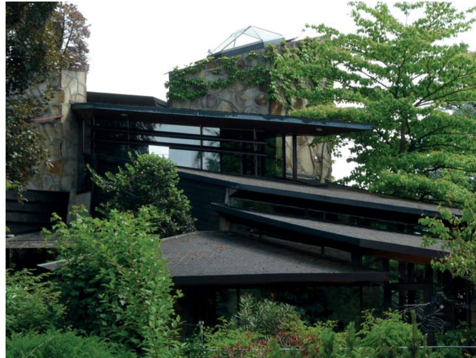
oben: die versetzten Dachflächen vom Wohnbereich, darüber der Elternbereich, mittig der Kaminkern mit Oberlicht für die Wendeltreppe
