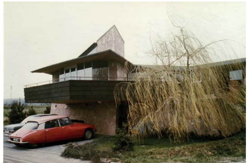
oben: Baustelle Haus Specht 1971, im Vordergrund ist das Außenschwimmbekken angeschnitten zusehen. unten: Das Haus Specht ist fertiggestellt. Fotos: Archiv Niemeyer
