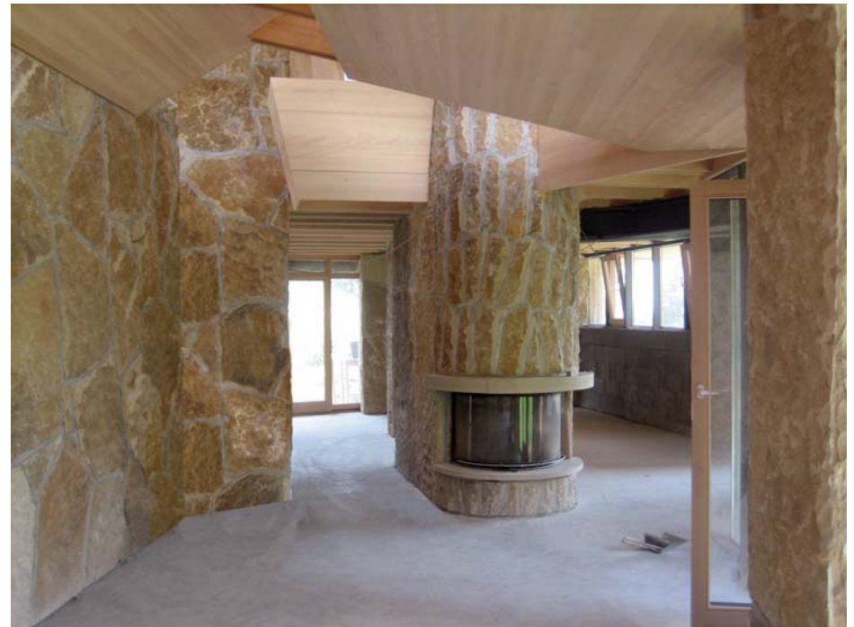
Wohnbereich im EG: Bruchrauer Naturstein für Wände, Pfeiler und Kaminkern - geschlossene Wände schirmen das Wohnhaus zu Werkstatt und Werkhof hin ab.
