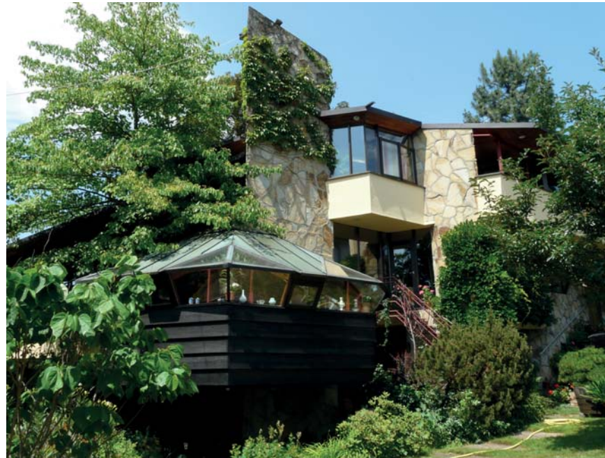
Südansicht Haupthaus mit zentralem Kaminkern und auskragendem Kaminplatz
