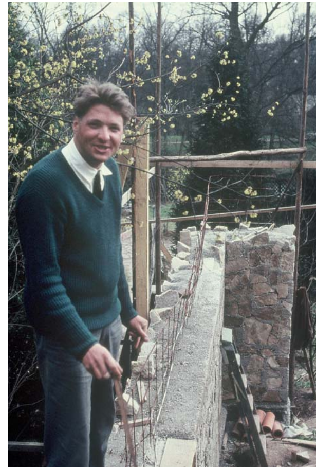
Heinrich Niemeyer auf seiner ersten Baustelle: Wandstück aus Naturstein- Beton-Mauerwerk
