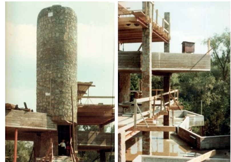
Baustelle Ansicht Nord, zentraler Kern und Pfeiler aus Naturstein-Beton-Mauerwerk, Träger und Stützen aus Stahl, Geschossdecken und Brüstungen aus Stahlbeton, Zwischenebenen - Holzbalkendecken
