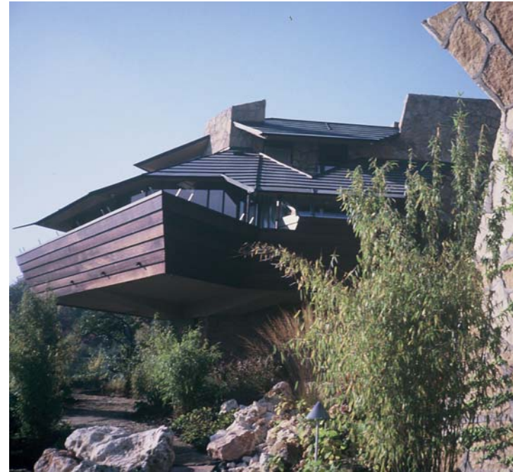
Formensprache: ,Schippernde Dächer', konisch verlaufende Wände und Brüstungen, Auskragungen
