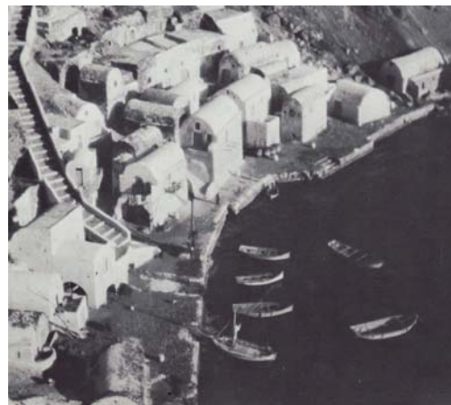
Fischerdorf Thera, Ägäisches Meer, Das ursprüngliche Gewölbe - die frühes- te Art des gewölbten Daches - kennzeichnet ein typisches Haus von Thera Rudofsky 1989 S.146
