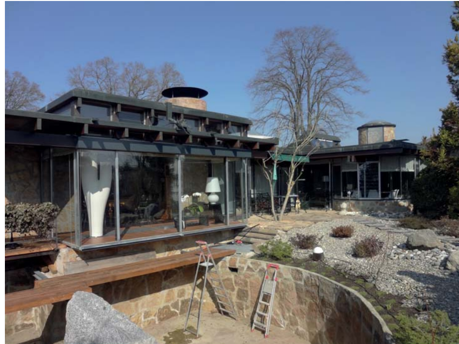
Ansicht Süd-West. Das Haus öffnet sich zum Gartenhof entlang der Diagonalen über eine 15 m lange Stahl-Glasfront. Im Vordergrund: Sanierung des Seerosenbeckens
