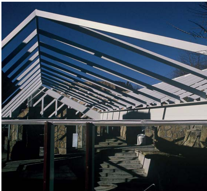
Stahlkonstruktion Dach Schwimmbad
