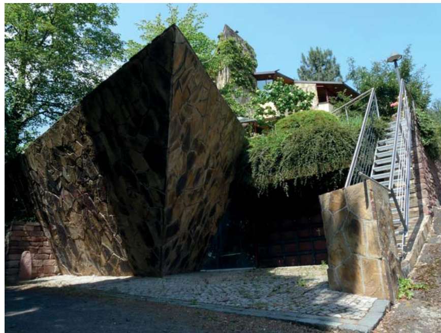
Steinbug mit Regenauffang- behälter für 2.000 Liter, Garage und südliche Zu- gangstreppe, 1991 ergänzt
