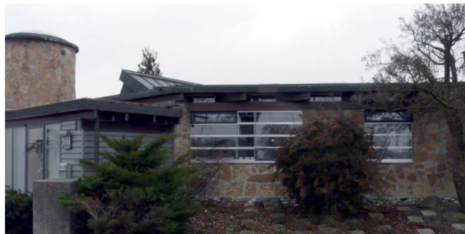
Ansicht Ost. Der überdachte Eingangsbereich links wurde später als Windfang geschlossen.
