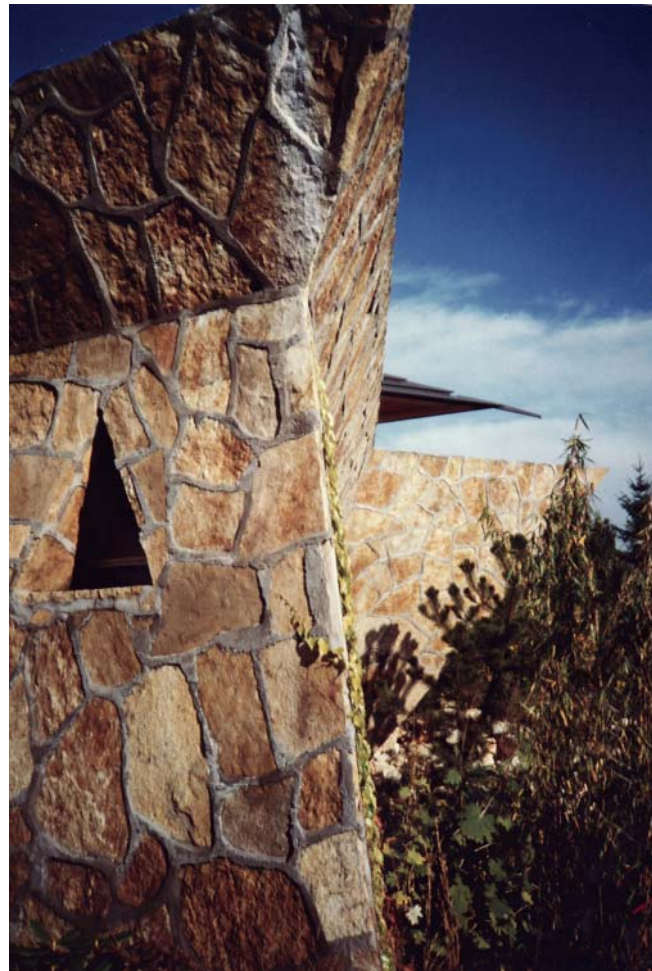
außen wie innen: Böden, Wände und Decken aus dem gleichen Material, bruchrauer Naturstein in einer tragenden Betonverbundkonstruktion links: konisch verlaufende Mauern am Hang, rechts: Galerie im Nordflügel
