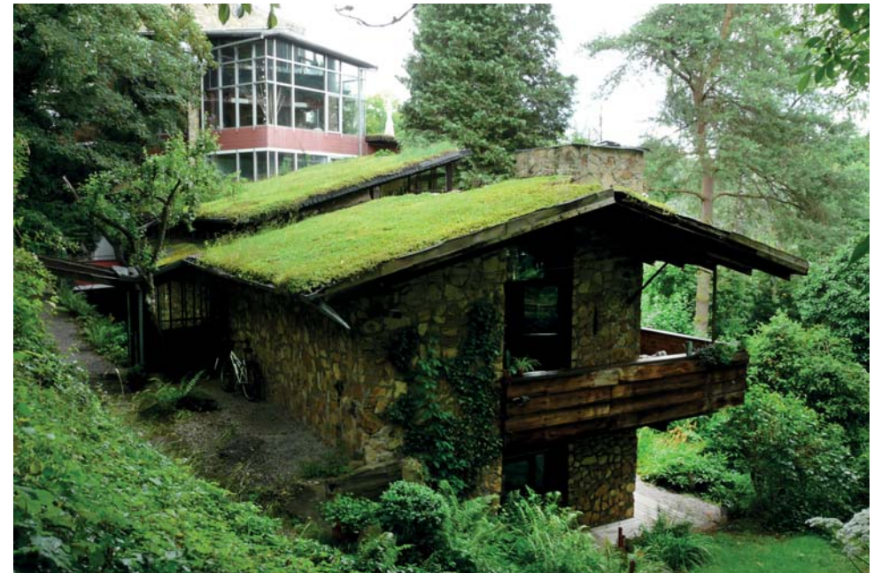
Ansicht Nord-West: Ensemble aus Haus Herb und Appartementhaus (1968) im Hintergrund,
