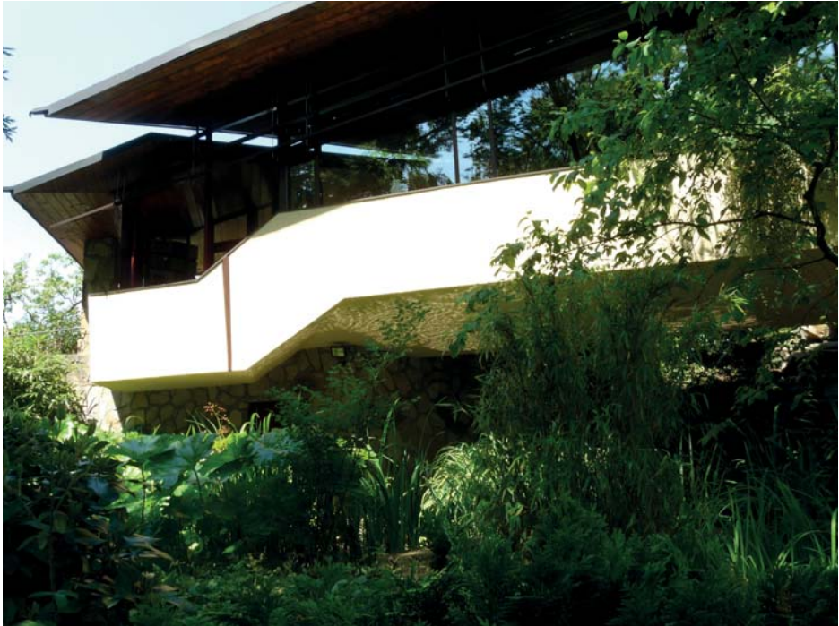
Der 12 m lange und 5 m hohe Wohnraum ist als Brücke ausgebildet. Ein Teich reflektiert das Licht unter die Wohnbrücke.
