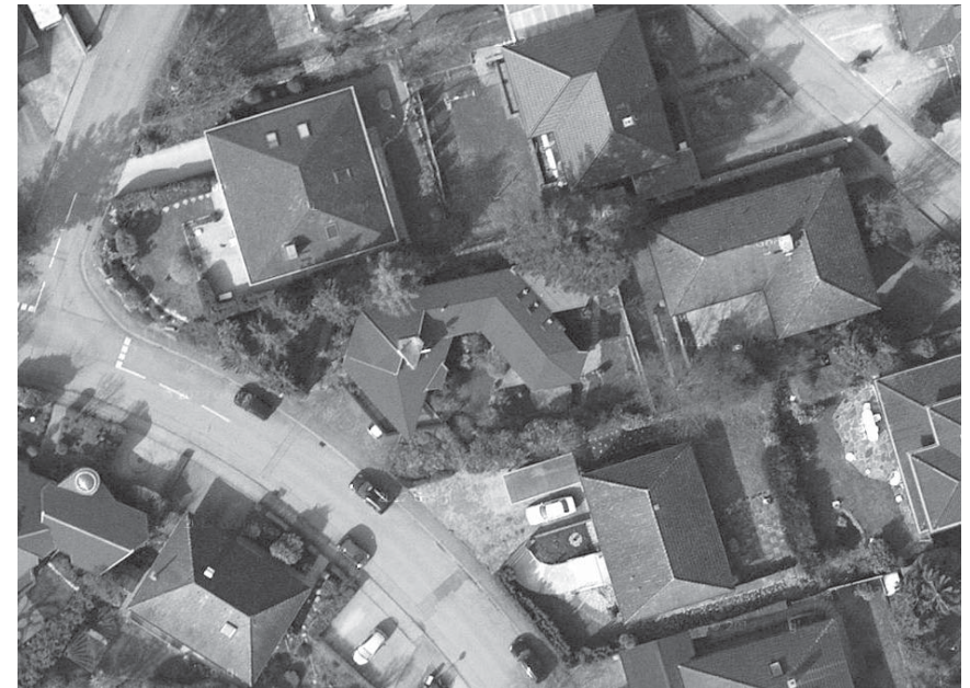
Der Eingang zum Haus ist nicht unmittelbar einsehbar. Eine Raumnische zum Straßenraum bietet Stellplätze. Foto: Archiv Specht
