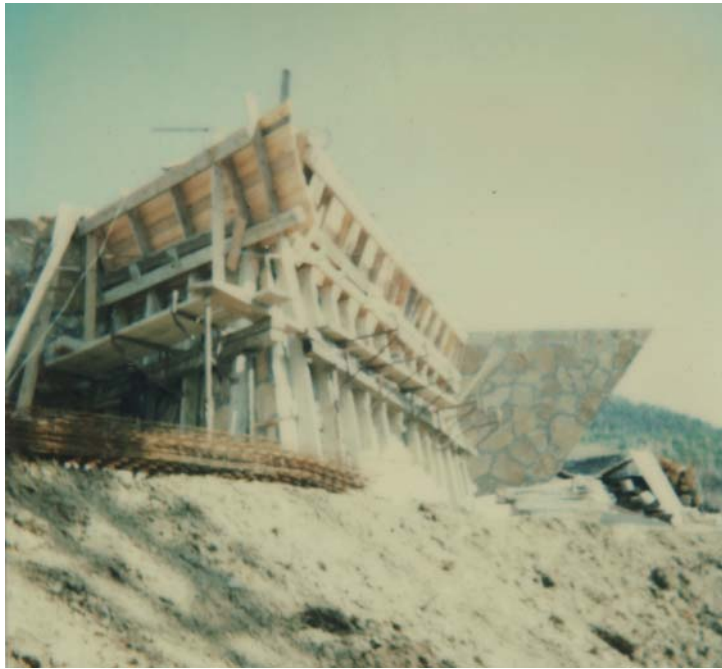
Baustelle Hülle, Verschalung des Naturstein-Beton- Mauerwerks
