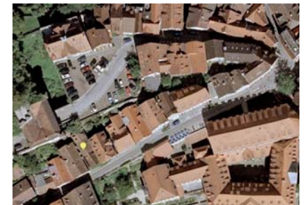
Engagierte Tübinger Bürger verhinderten den Abriss mittelalterlicher Fachwerkhäuser durch Erwerb, Beispiel Neckarhalde
