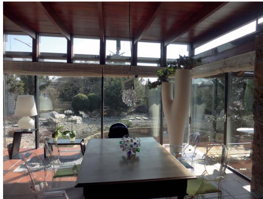
Randlose Verglasungen, schmale Stahlprofile und Oberlichtbänder verweben Innen- und Außenraum entlang des Gartenhofs
