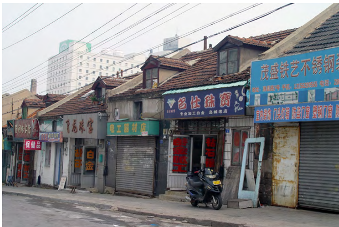
↑ Erweiterung der Liyuan-Wohnhäuser
