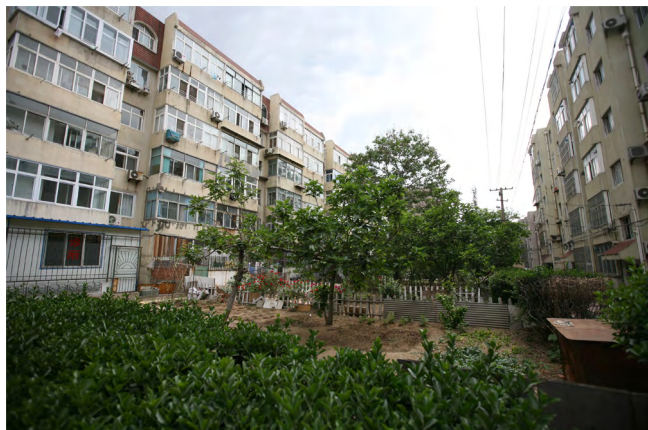
↑ Abb.119. Freiraum und Umgebung in den 80er Jahren: Invasion der öffentlichen Fläche
