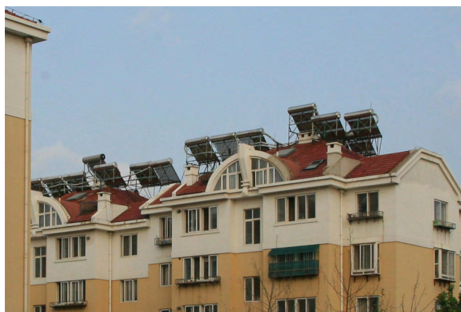
↑ Abb.159. Wohngebäude und Energieeinsparung: selbe eingerichtete Warmwassersolaranlagen
