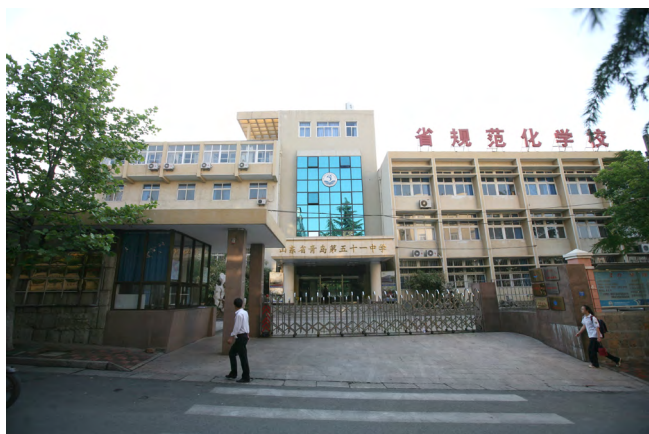
↑ Abb.117. Mittelschule Quelle: Untersuchung 3, Eigene Aufnahme, 2011
