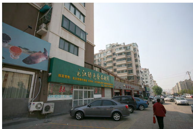
↑ Abb.113. Kommerzielle Randbebauung Quelle: Untersuchung 3, Eigene Aufnahme, 2011
