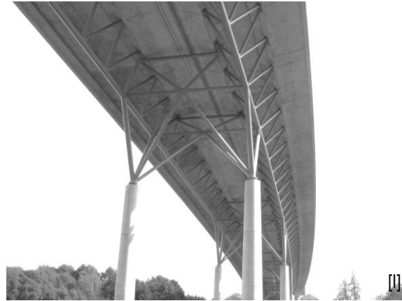
Bild 1-3: Konzentrierte Lasteinleitungen an Pfeilerköpfen
