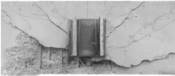
Bild 5-24: Versuch R6-2-1 mit Betonkantenbruch auf der lastabgewandten Seite
