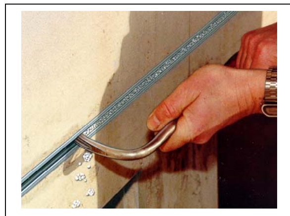
Bild 2.20: Vollschaumfüllung
