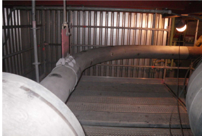
Bild 81: Stand der A-Leitung vor der Instrumentierung
