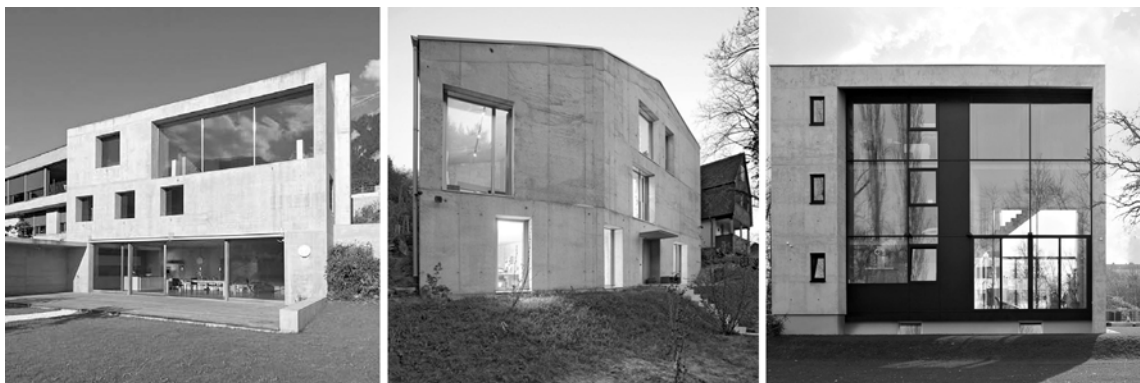
Abb. 3-8 Gebaute Beispiele in monolithischer Leichtbetonbauweise (von links): Haus Gartmann - Haus Trager - Haus Schlaich (Quelle Liapor)
