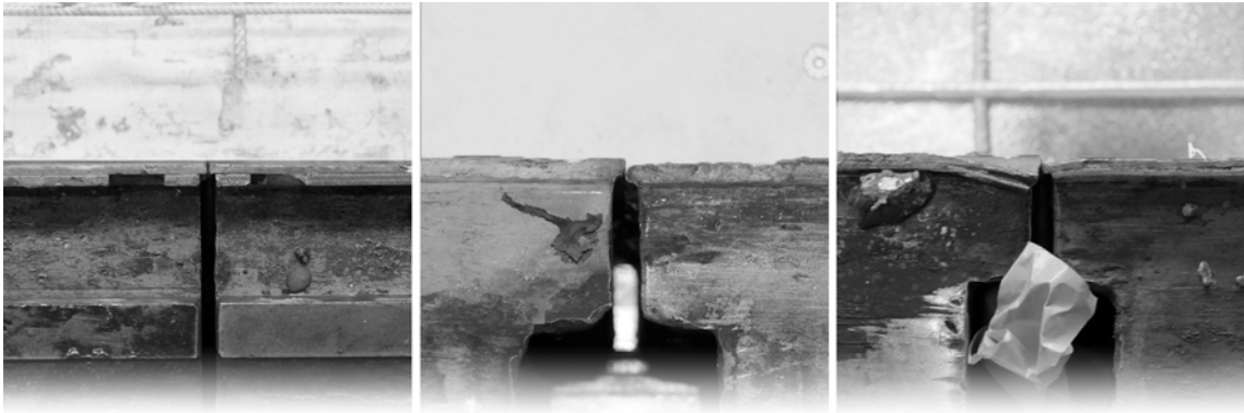
Abb. 6-6 Erscheinungsformen von Stoßfugen – passgenau (links) – Versatz (Mitte) – Eindellung (rechts)
