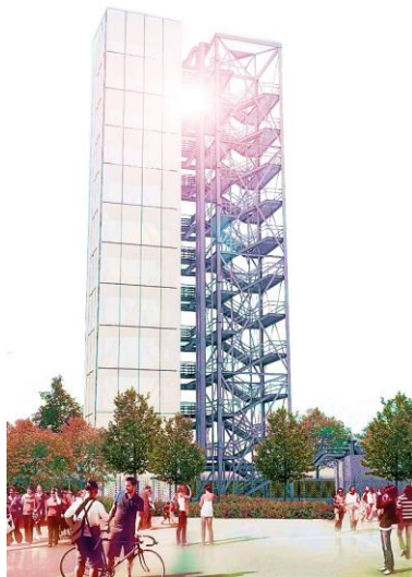
Bild 5.1: Hochhaus-Demonstrator (l) und Treppenturm (r) des SFB 1244 [89] unter Angabe der Eigengewichte und Nutzlasten nach [78, 93]
