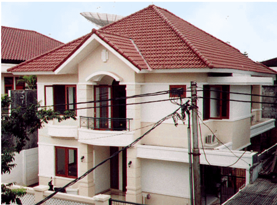
Abb. 15: Ein neues Haus aus Ziegelmauerwerk in Semarang [25]
