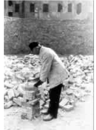
3 Ein Mann reinigt und sortiert Trümmersteine für den Bau der Notkirche in Berlin.
