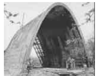
23 Emil Steffann: St. Bonifatius in Lübeck (Baustelle), 1951
