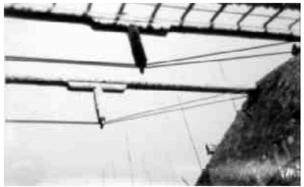
57 Unterspannte Dachkonstruktion in der Scheunenkirche in Boust. Foto von Steffann aus seiner "Baufibel für Lothringen".
