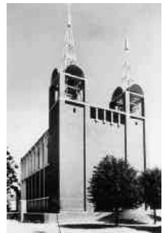
27 Alfons Leitl: St. Martin in Aldenhoven, 1948-1953
